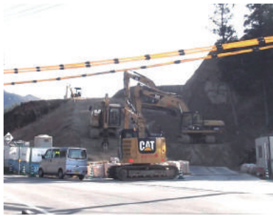
工事が進む喜多バイパス
