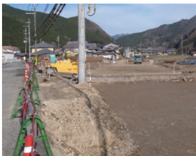
天船バイパスの改良工事
