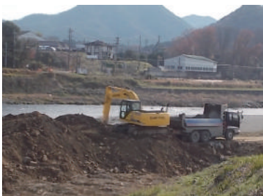
加古川の河床掘削が進んでいます(写真:西脇市黒田庄町福地地区)
